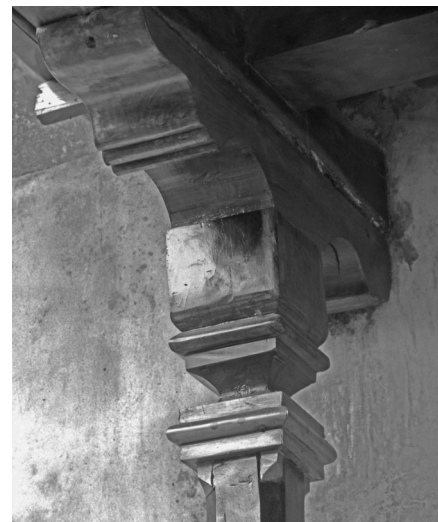
Zapata que sostiene el balcón.
