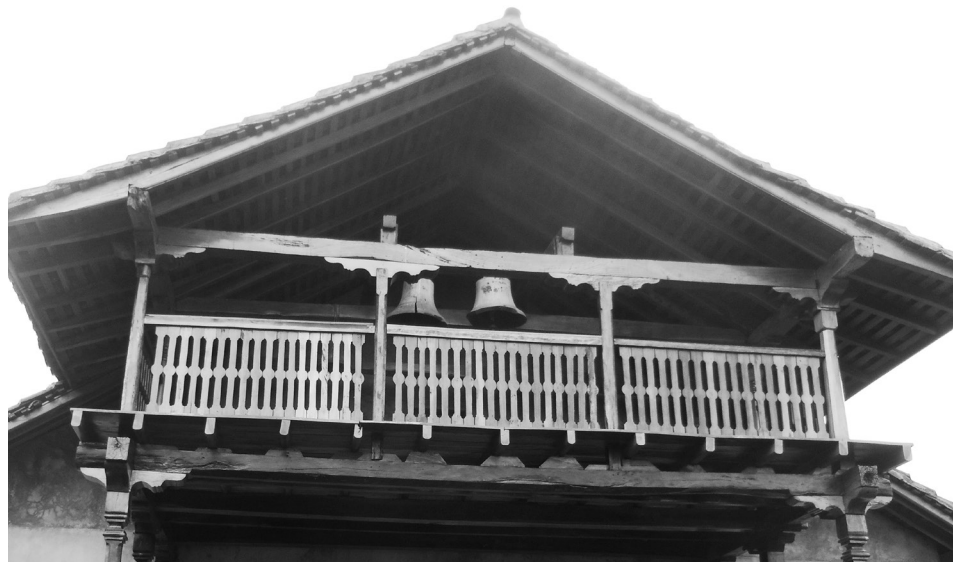
El balcón todo elaborado en madera, con su baranda compuesta de balaustrada de tablillas con diseño geométrico.
