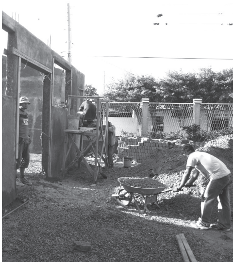
Avance de la ejecución del proyecto del CDI.
